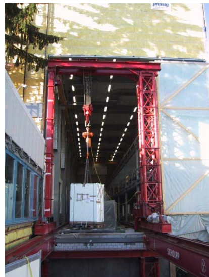
Einbringöffnung für Rotationsmaschine
