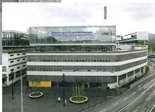
Ansicht von der Giesshübelstrasse
