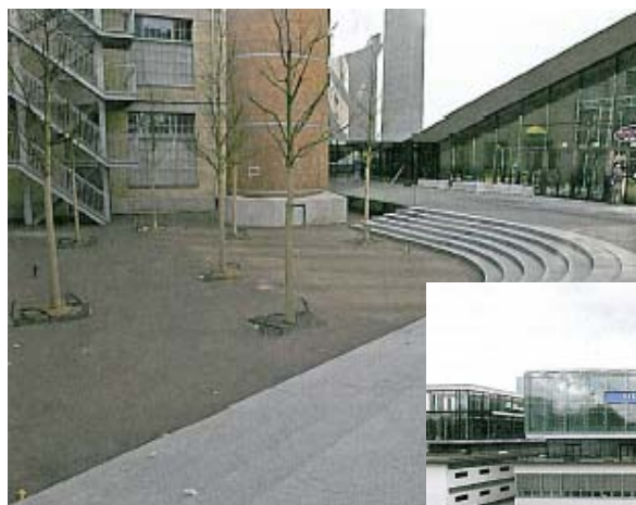
Sanierte Gebäude der ehemaligen Sihlpapier AG
